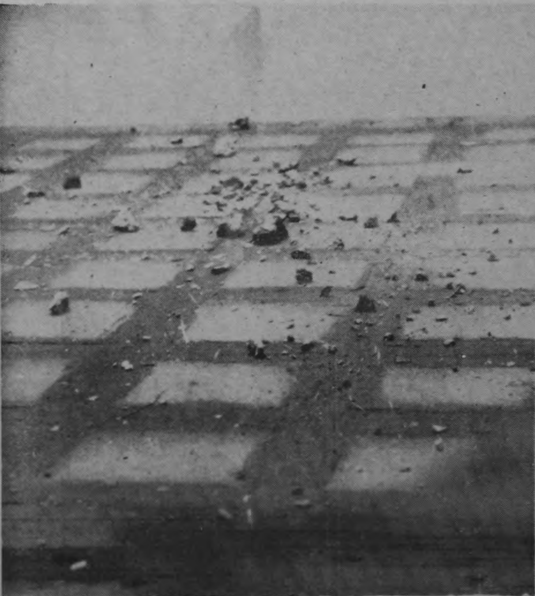
Regueros de pedazos de piedras quedaron sobre el techo de "La Voz de la Victoria". Afortunadamente los daños fueron de poca consideración de-
