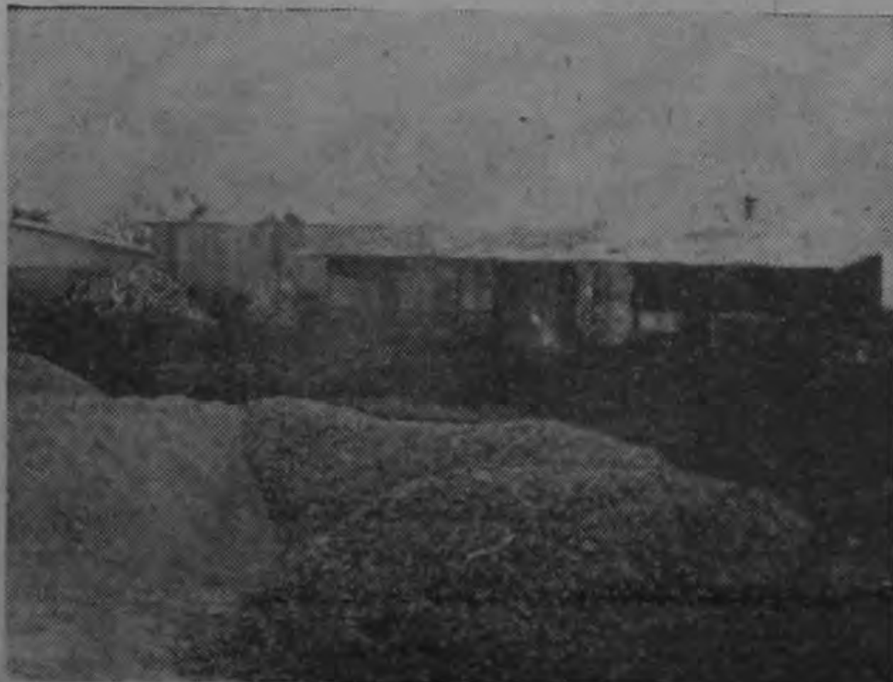
Los trabajos del nuevo edificio municipal, en el centro de Escazú se iniciaron. Allí se alojarán las principales oficinas públicas, como de administración, telégrafos, etc.
