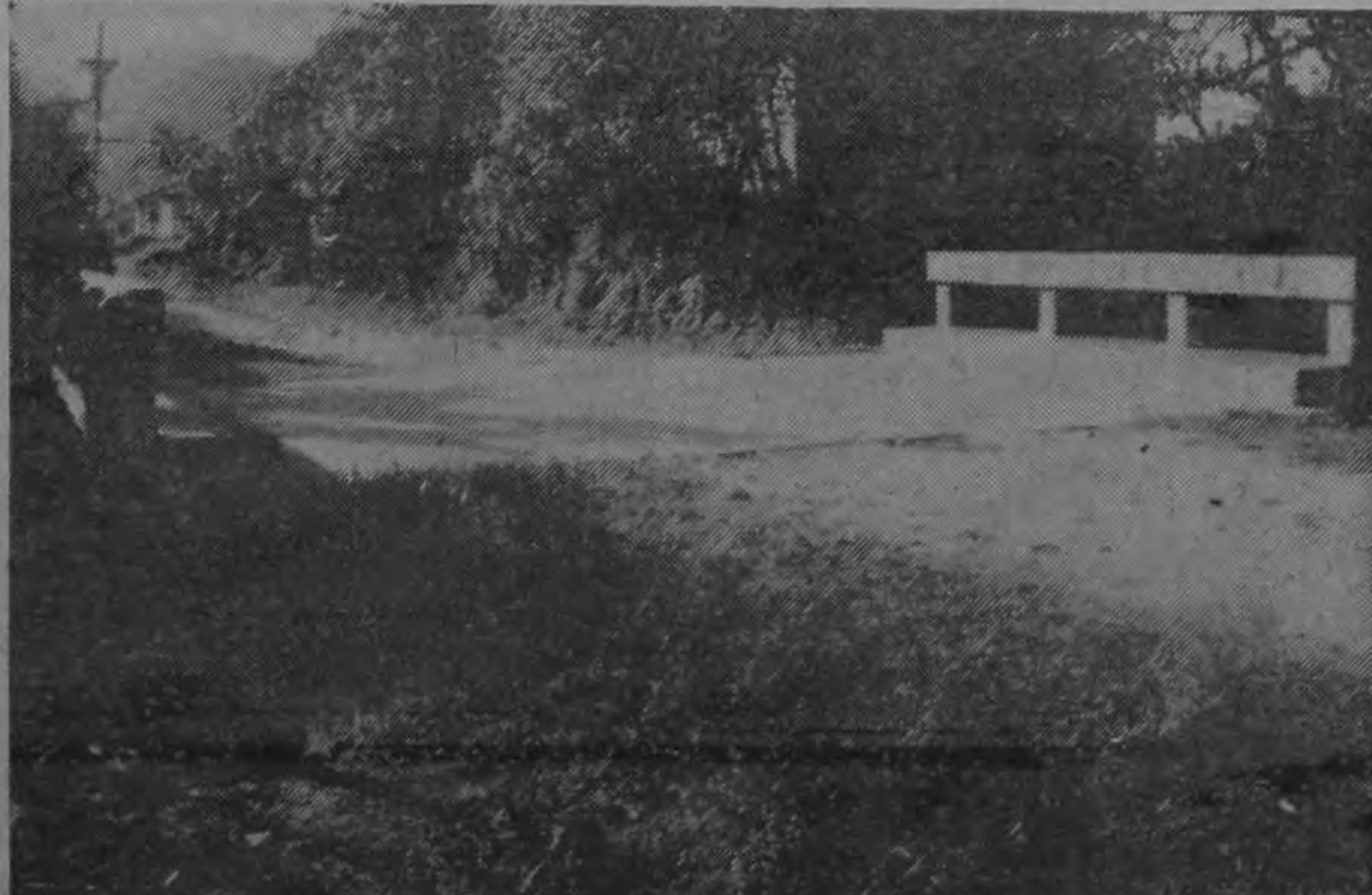
Otra obra de vital importancia realizada por la Municipalidad de Escazú: el puente de San Antonio.
