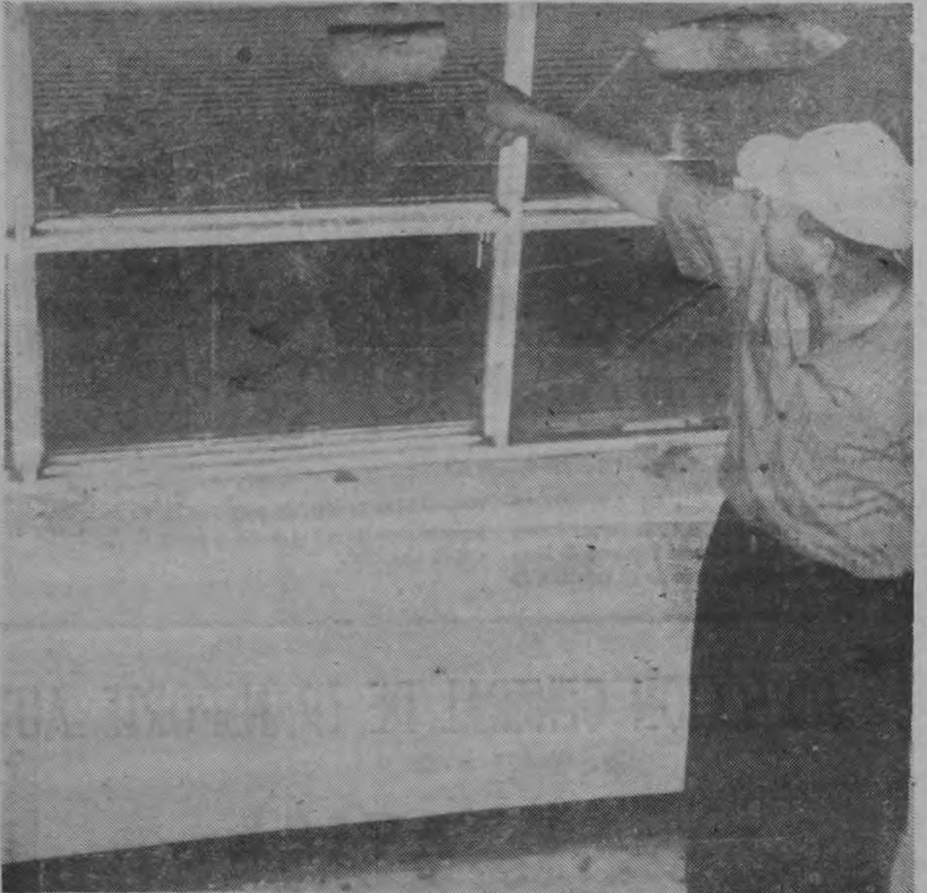
UN GUARDA PARTICULAR SEÑALA LOS DESTROZOS. Los daños en la estación de radio "La Voz de la Victor" fueron causados por piedras que lanza-
